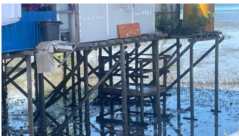
Sanitasi terbuka di tepian air (Bulungan, Kalimantan Utara)
